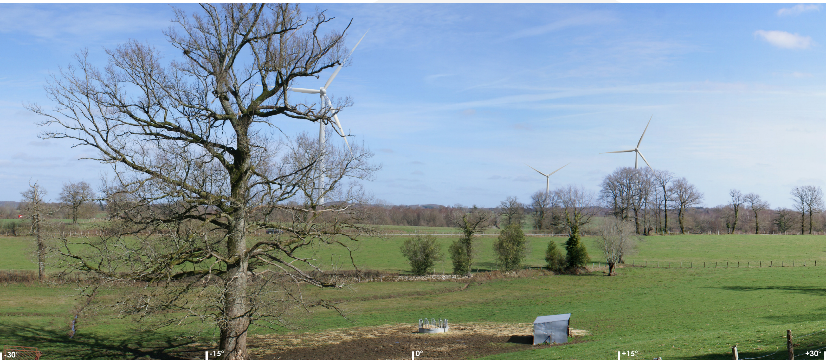
Montage 60° - éoliennes renforcées
